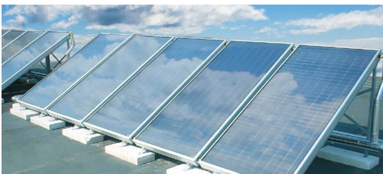
Esempio di installazione su superficie piana
