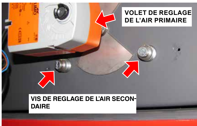
VIS DE REGLAGE DE L'AIR SECONDAIRE
