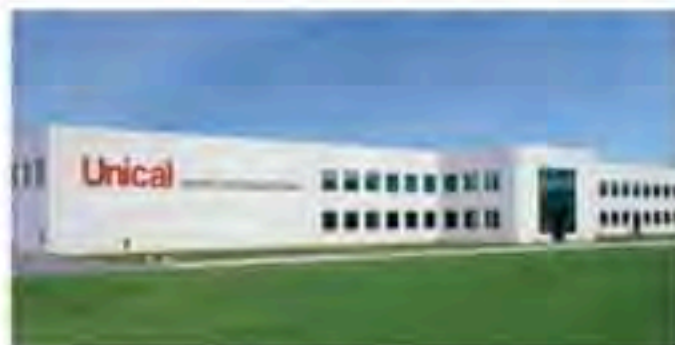
Stabilimento Unical di Caserta
