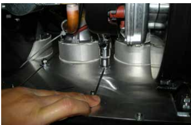
- Rimuovere le viti "A" per ogni elemento (con chiave a tubo da 13 mm)
