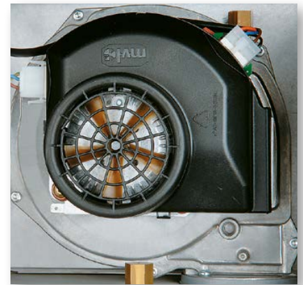
Lückenlose Steuerung der Verbrennung, Low-NO x - Klasse 6 (Vormisch-Brenner und modulierendes Gebläse)
