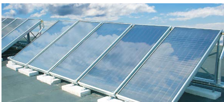
Esempio di installazione su superficie piana
