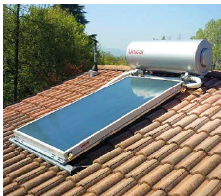
Kit installato a tetto
