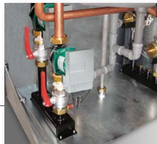
Pumpen und Absperrhähne
