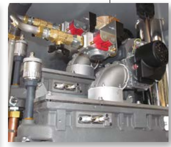
Baugruppe aus: Gebläse, modulierendem Gasventil, Vormisch-Brenner
