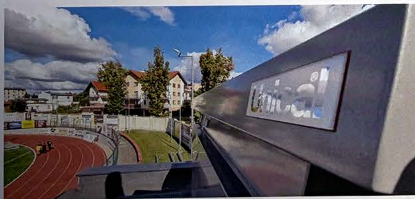
Stadio del Club Sportivo Chojniczanka Chojnice 1930. Questo è un esempio di utilizzo di MODULEX EXT, dove la caldaia da 900 kW assicura che il campo sia riscaldato e sempre pronto per il gioco, indipendentemente dal gelo.
