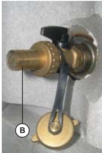
Rubinetto di scarico posizione scarico bollitore
